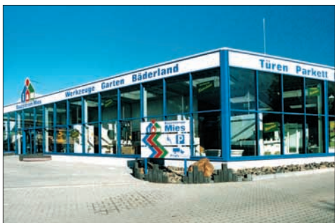
Bauzentrum Mies in Hachenburg.
