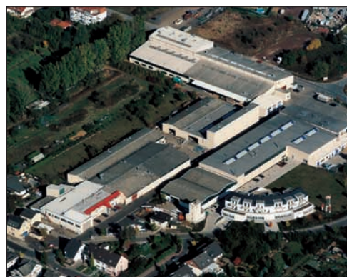
Blick auf das Höfer-Werksgelände in Urmitz Ende der 90er Jahre.
